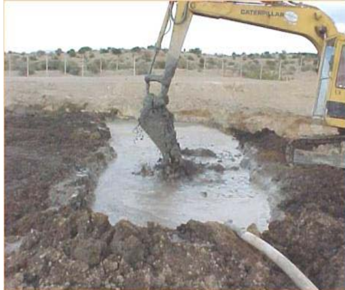
Foto 1: Aplicación de estabilización/solidificación en operación discontinua utilizando retroexcavadora y reactivos mezclados con agua.
