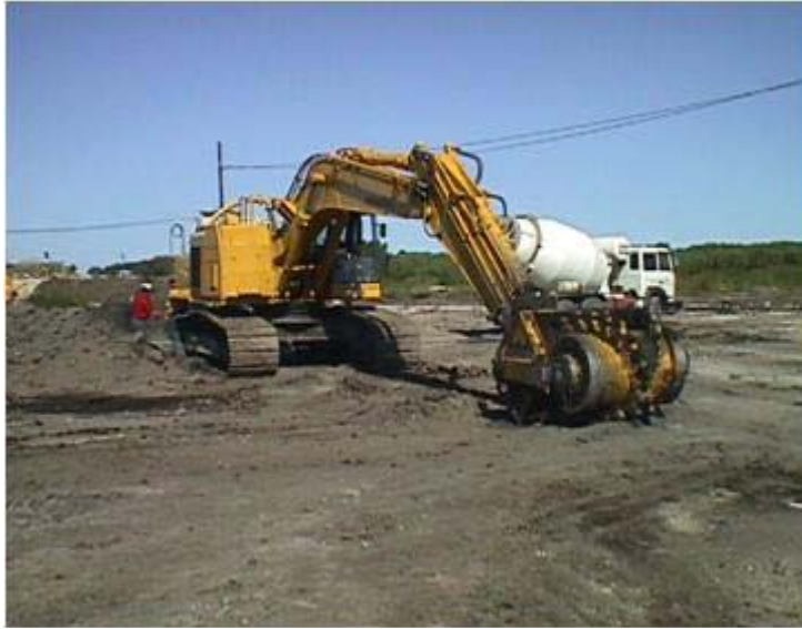
Foto 3: Aplicación de estabilización/solidificación en operación continua utilizando retroexcavadora con rodillo hidráulico.
